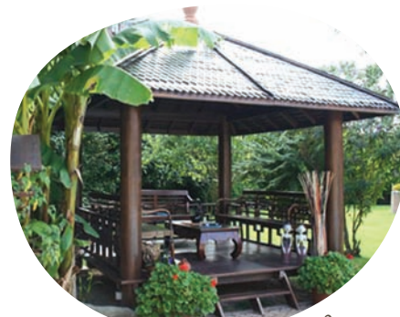
Exemple de réalisation
