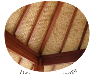
Détail sous toiture
